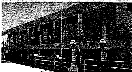
Construcción y sustitución de la Infraestructura de la I.E. Inca Garcilazo de la vega – Puca Cruz (Continuidad)
